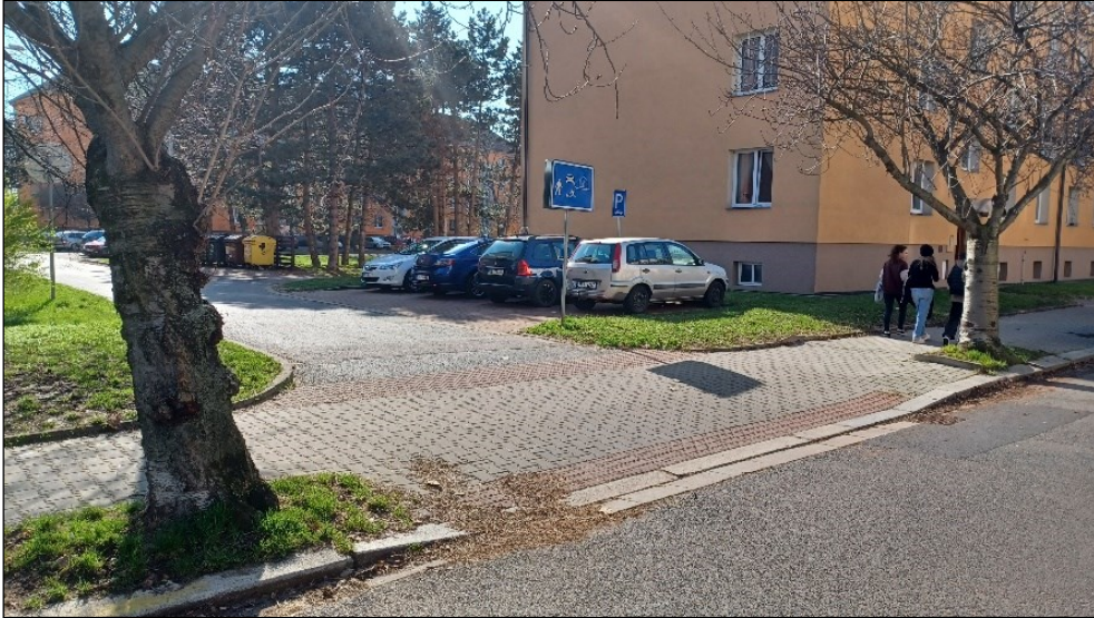
Obrázek 89 Vjezd do obytné zóny chodníkovým přejezdem (Pardubice), zdroj: Jakub Kutílek
