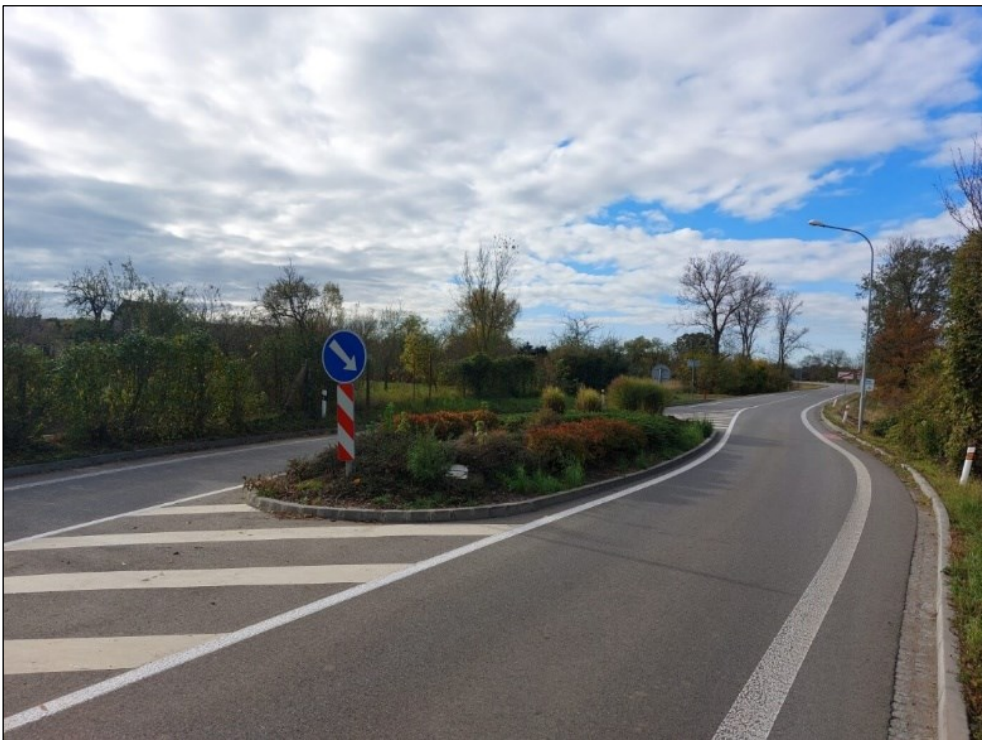
Obrázek 62 Oboustranný vjezdový ostrůvek (Podivín), zdroj: CDV
