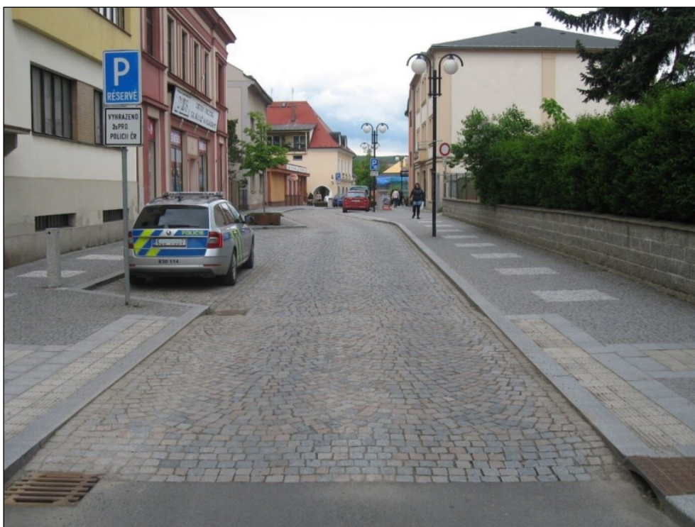
Obrázek 69 Zvýšená plocha a změna povrchu komunikace na začátku dopravní zóny (Česká Třebová), zdroj: CDV
