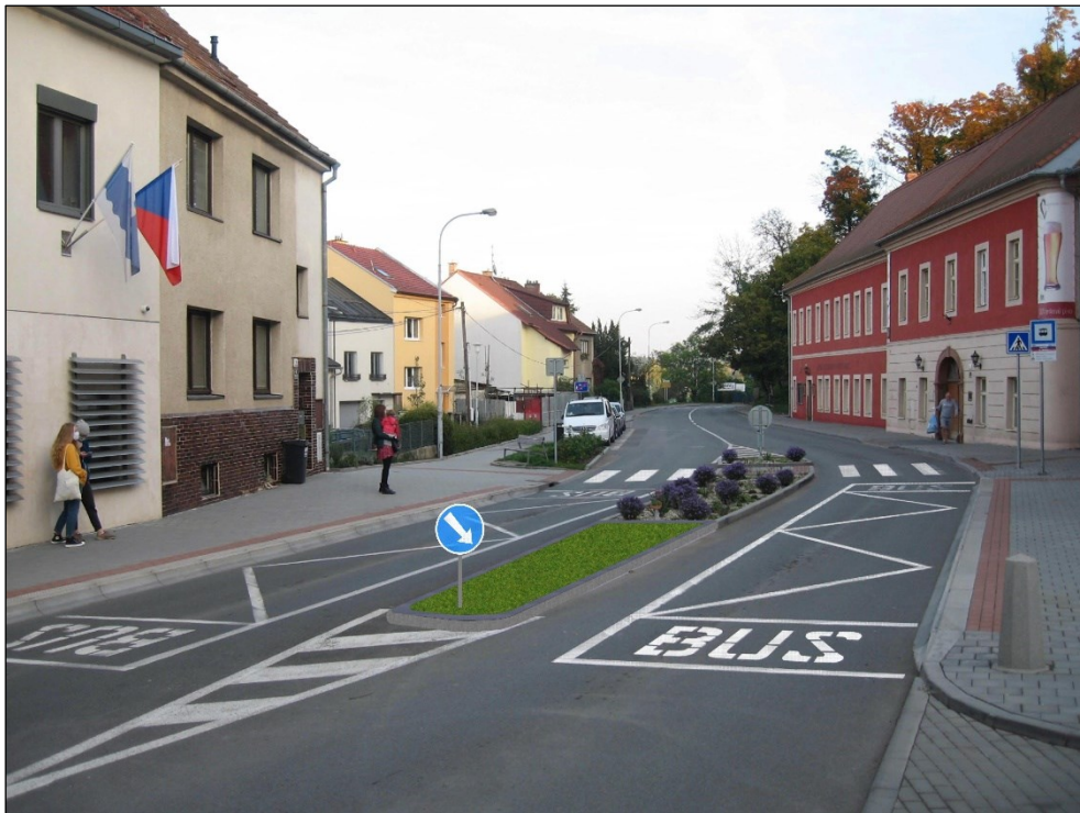
Obrázek 73 Zastávka VHD typu zátka ve vstřičné poloze se zastávkovým obrubníkem (Brno), zdroj a úprava: CDV
