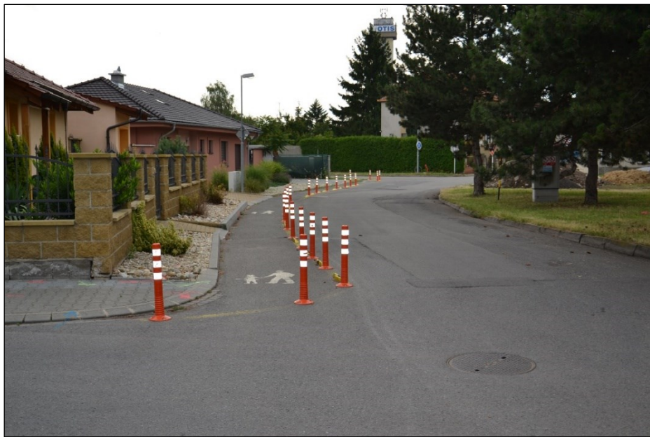
Obrázek 16 Provizorní nestavební úprava s vytvořením pásu pro chodce (Břeclav), zdroj: CDV
