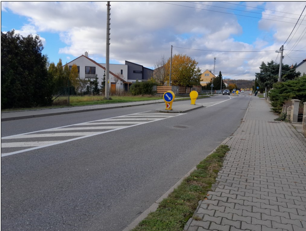
Obrázek 59 Série ostrůvků spolu s vysazenými plochami vytvářejícími šikanu (Ochoz u Brna), ostrůvek lze využít jako místo pro překonání komunikace zdroj: CDV
