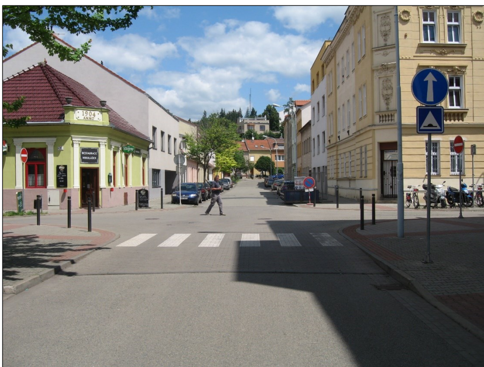
Obrázek 70 Zvýšená křižovatková plocha s vyznačeným přechodem pro chodce a nevyznačenými místy pro přecházení mimo zónu s omezením rychlosti (Brno), zdroj: CDV
