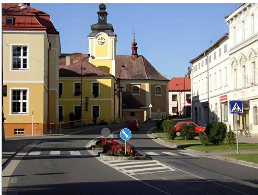
Obrázek 10 Ochranný ostrůvek na přechodu pro chodce na průtahu I/43 (Březová nad Svitavou), zdroj a úprava: CDV
