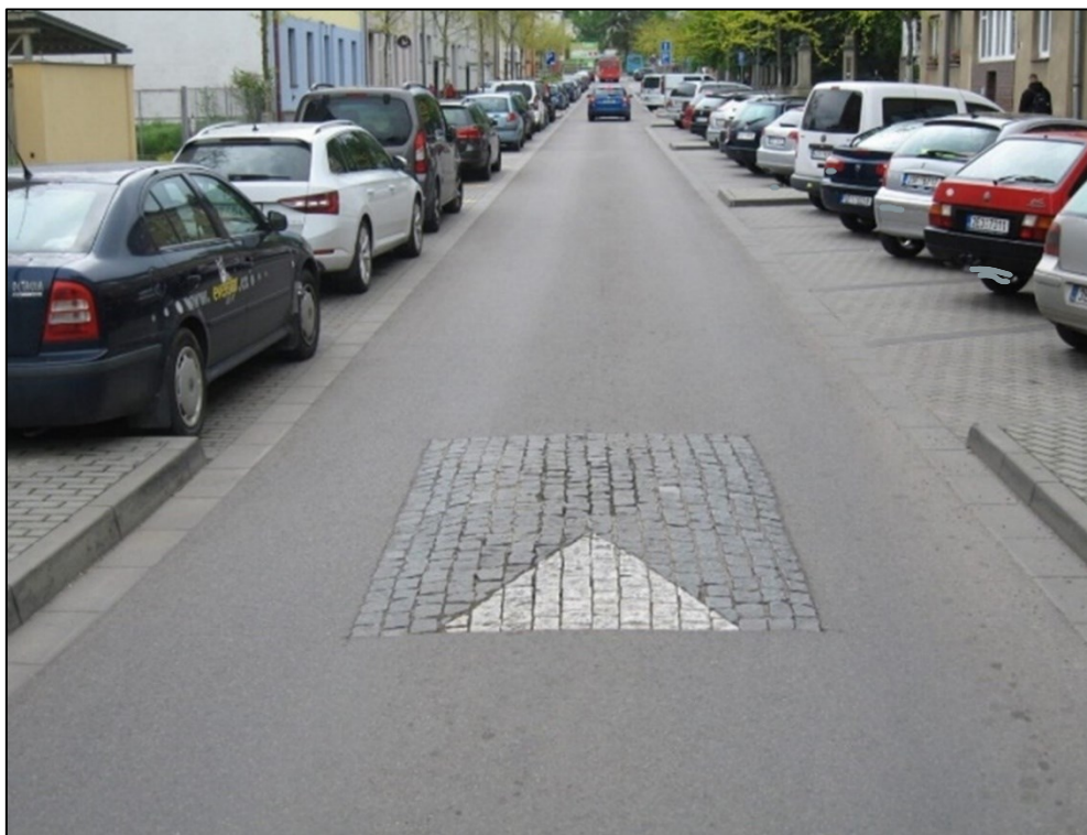
Obrázek 72 Zpomalovací polštář (Chrudim), zdroj: CDV
