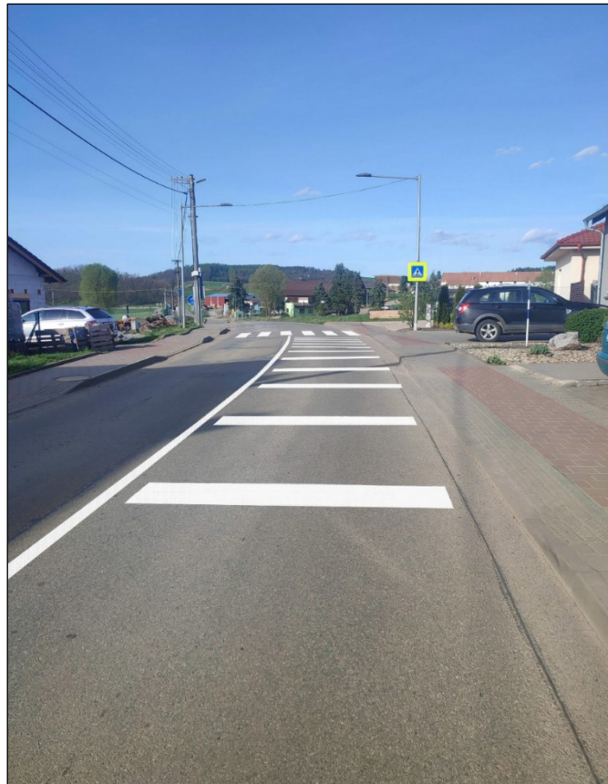
Obrázek 7 Optická psychologická brzda upozorňující na přechod pro chodce (Malhostovice), zdroj a úprava: CDV
