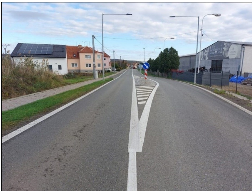
Obrázek 9 Jednostranně vychýlený ostrůvek před vjezdem do obce (Velké Pavlovice), zdroj: CDV
