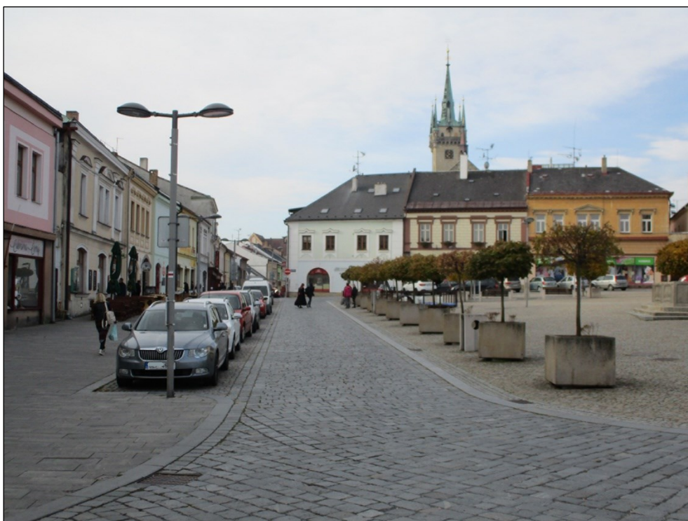
Obrázek 83 Zrekonstruované náměstí vč. přilehlých ulic (Polička) – obytná zóna s omezením vjezdu, zdroj: CDV
