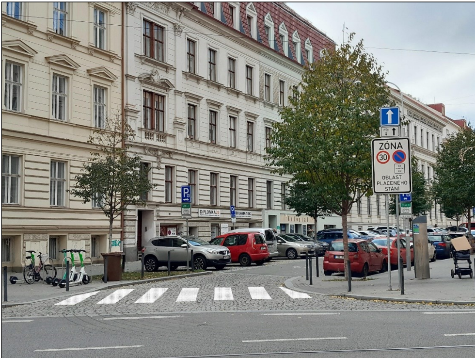
Obrázek 78 Řešení vjezdu do zóny pomocí změny povrchu vozovky (dlažbou) s integrovaným přechodem (Brno), zdroj a úprava: CDV
