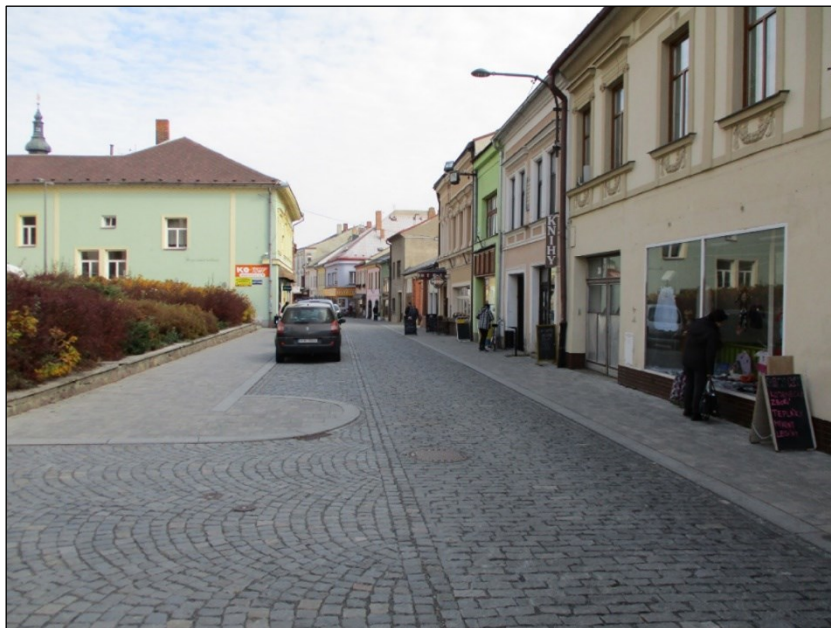
Obrázek 40 Parkovací pruh odlišený dlažbou a zapuštěnou obrubou, v době zpracování TP označeno jako obytná zóna s omezením vjezdu (Polička), zdroj: CDV
