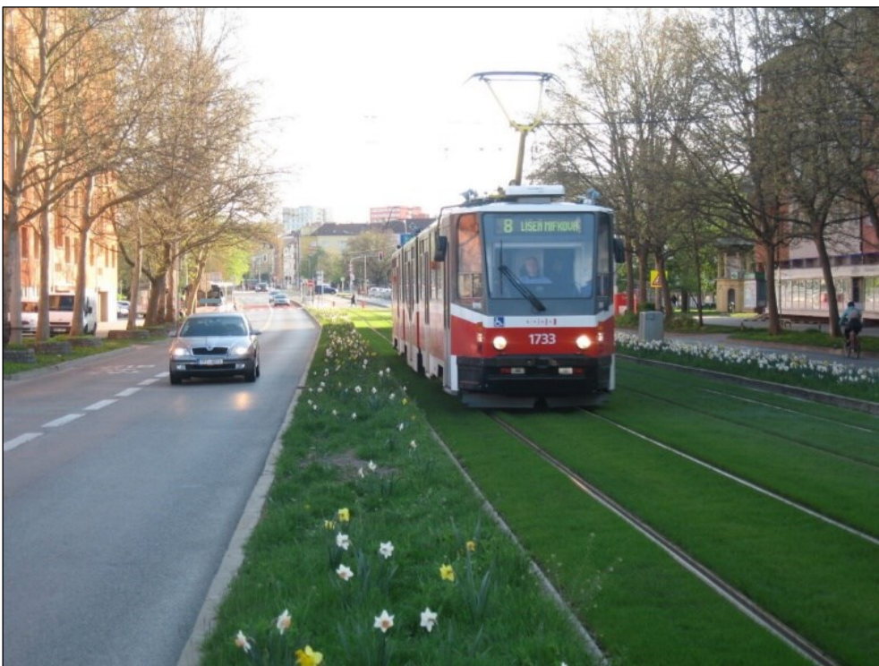
Obrázek 68 Střední dělicí pás s tramvajovým pásem (Brno), zdroj: CDV
