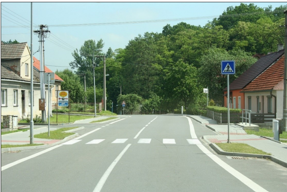
Obrázek 60 Lokální zúžení v místě přechodu pro chodce (Opatovice), zdroj a úprava: CDV
