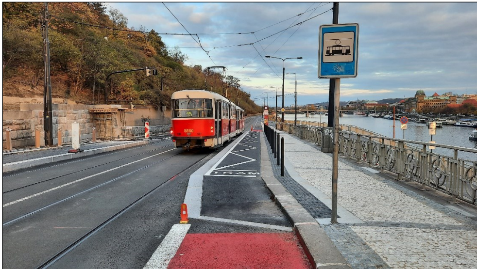
Obrázek 75 Tramvajová zastávka VHD se zvýšeným cyklistickým pásem (Praha), zdroj: Tomáš Cach
