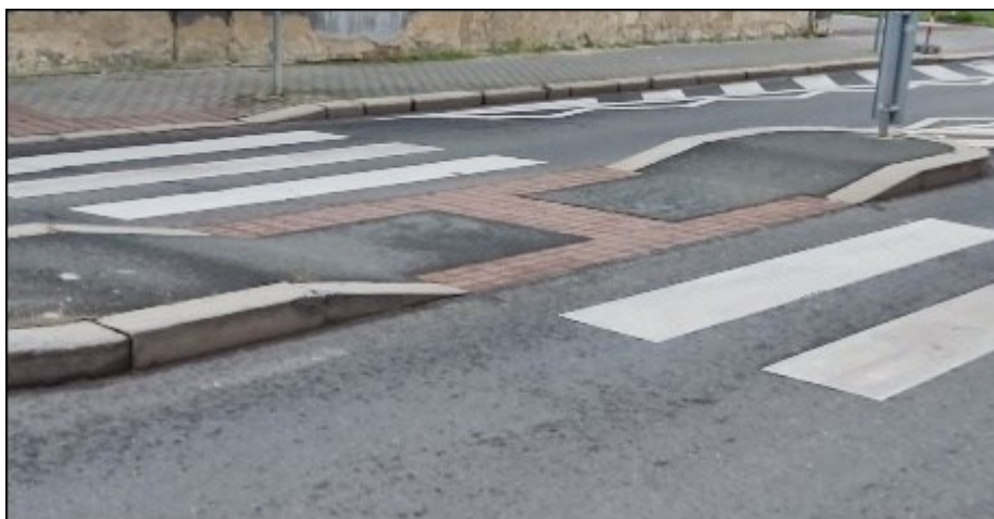
Obrázek 109 Řešení obrub ochranného ostrůvku výškovými náběhy obrubníků
