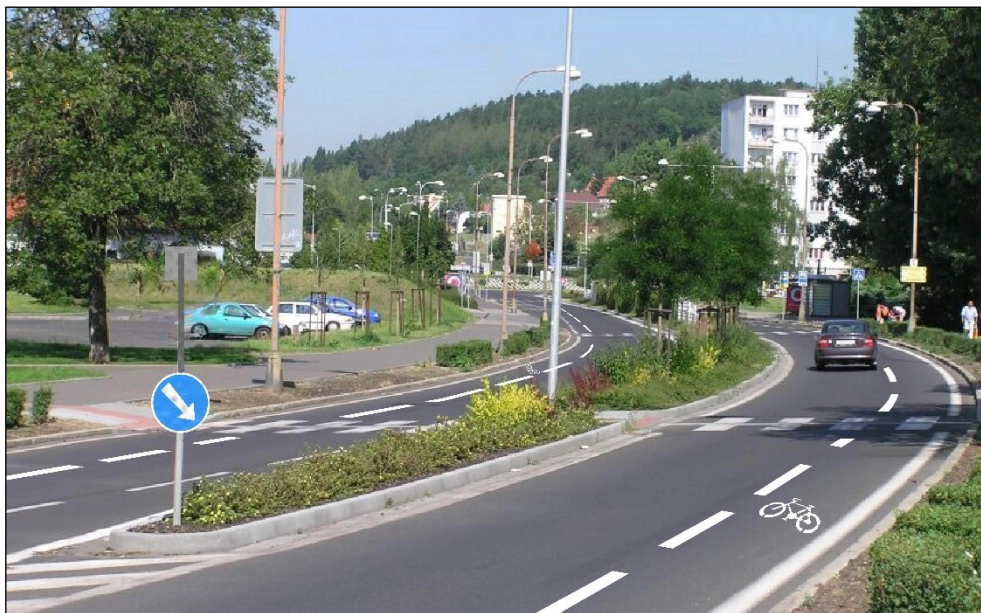
Obrázek 1 Střední dělicí pás s přechodem pro chodce (Kadaň), zdroj a úprava: CDV
